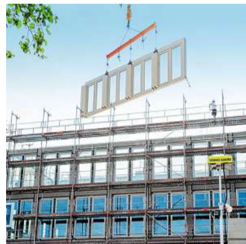
Die Bauteile wurden vom Laster gehievt und sofort montiert.
