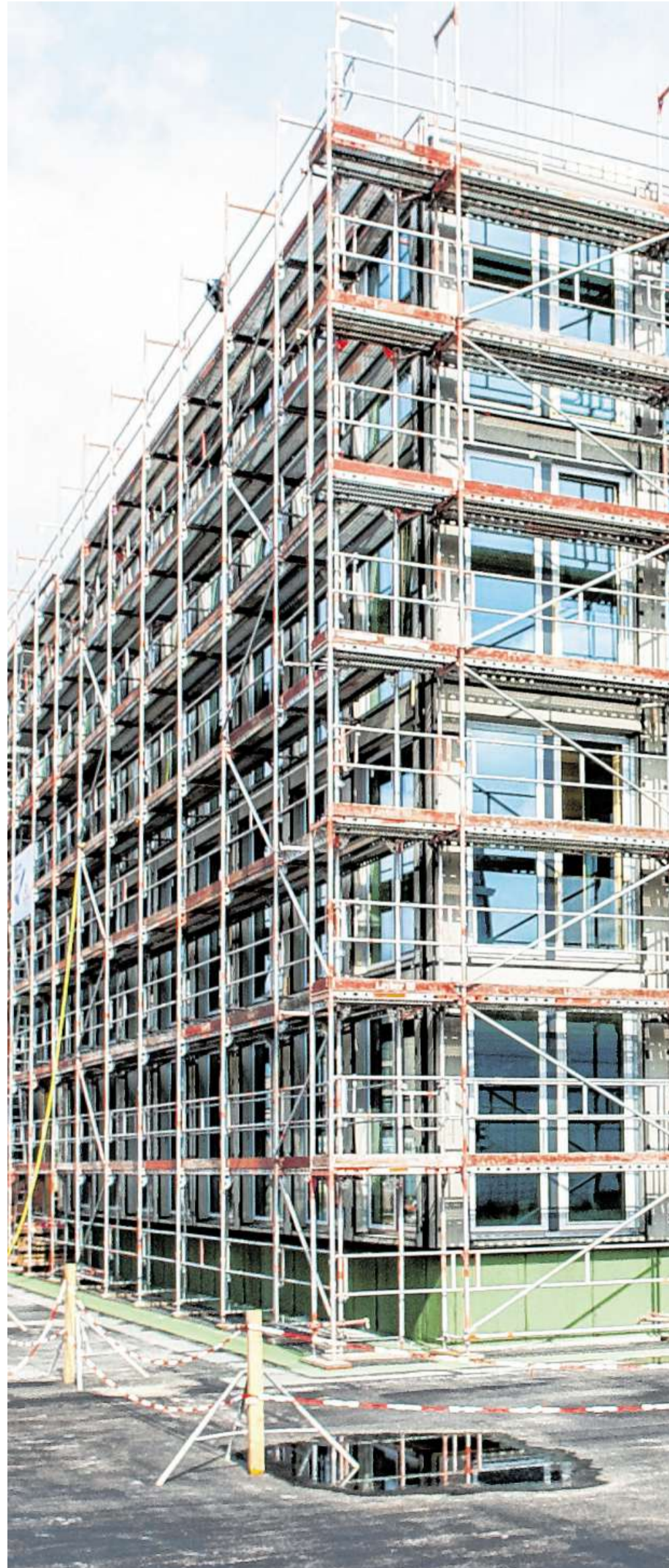
Vier Etagen mit rund 3200 Quadratmetern Bruttogeschossfläche – das Ergebnis von zehn Tagen Bauarbeit. FOTOS: CHRISTINA KUHAUPT (3)
